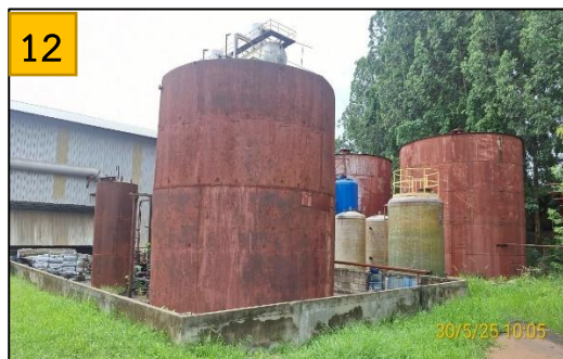
ถังเก็บน้ำมันเตาและพื้นที่ลานถัง
